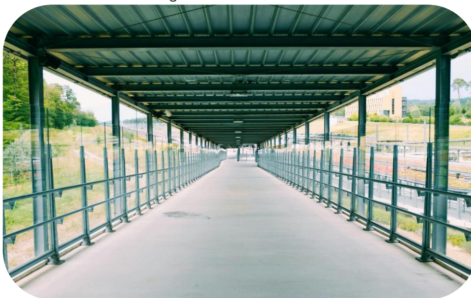
Imagem 13: Telhado de metal
